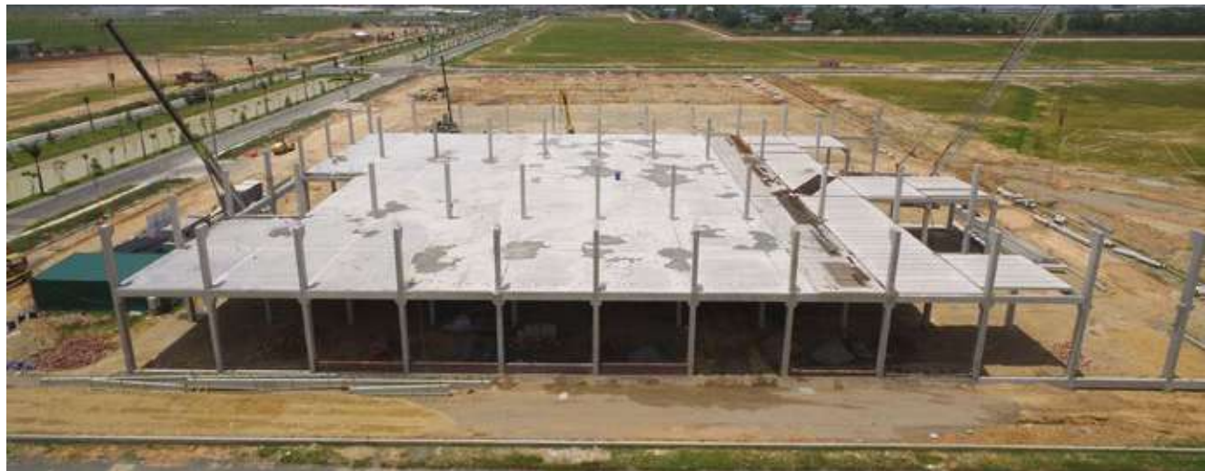
Công trình CNCtech ThangLong 3 tháng 05.2020
